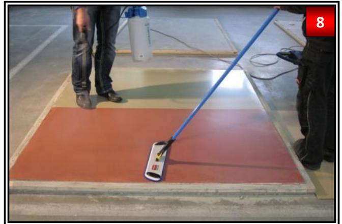
Zweitapplikation von OBTEGO® R-400 wie unter Schritt 2-6, jedoch im Kreuzgang zur Erstapplikation. Materialverbrauch bei der Zweitapplikation liegt bei ca. 20-30 ml/m<sup>2</sup>.
