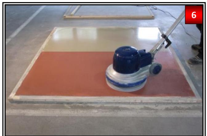
Noch vor dem Antrocknen (je nach Temperatur und Luftfeuchtigkeit zwischen 2 – 10 min.), den öliges Film mit einer Einscheibenmaschine und einem weißen Pad einpolieren.
