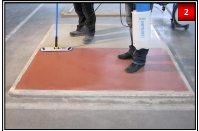
OBTEGO® R-400 mit einem Drucksprüngerät gleichmäßig auf die Oberfläche auftragen und mit einem Mikrofaserwischer einarbeiten. Empfohlene Flachstrahldüse 0,1.
