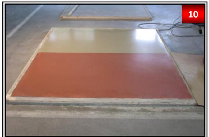
Die Trocknungszeit bis zur Begehbarkeit beträgt in der Regel ca. 7 Stunden, kann jedoch je nach Umgebungstemperatur, Luftfeuchtigkeit und Materialverbrauch variieren. Den behandelten Belag 48-72 Stunden nicht stark belasten oder abdecken. Außerdem sollte auch bis dahin nicht mit Reinigungsautomaten gefahren werden.
