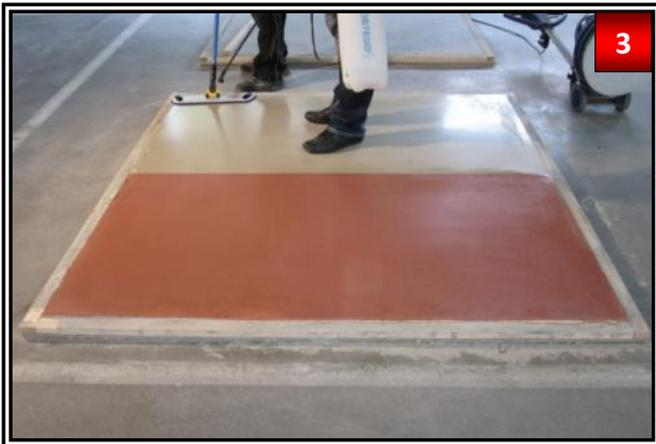
Der Materialverbrauch liegt bei der ersten Applikation bei ca. 40-50 ml/m<sup>2</sup>. Die Applikation erfolgt in Bahnen. Die Bahnbreite ergibt sich automatisch durch den Wischer (ca. 1 m).
