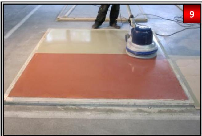
Beim Einpolieren auf gleichmäßige Optik achten. Starke Überschüsse, Spritzer oder Padsuren sind zu vermeiden. Bei zu langem Einpolieren kann das Pad schnell verkleben und die Oberfläche etwas matter erscheinen.
