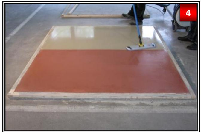
Der Bodenbelag muss mit R-400 gesättigt sein, jedoch kein starker Überschuss. Bei Überlappung darauf achten, dass kein Materialüberschuss auf der Fläche stehen bleibt.
