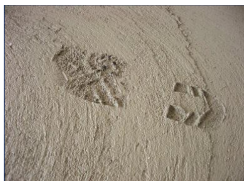
Image 2 : Lissage du béton à l'aide de la lisseuse à disque
