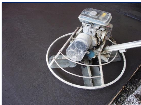
Image 9 : Lissage de la couche en agrégats durs à l'aide de la lisseuse à disque. (finisseur de béton)
